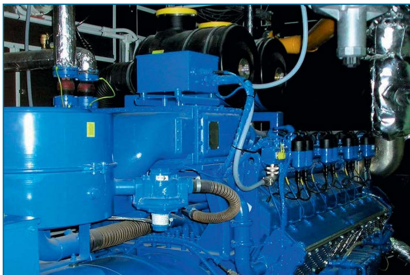
Rys 2. 16-to cylindrowy silnik gazowy kogeneratora.
