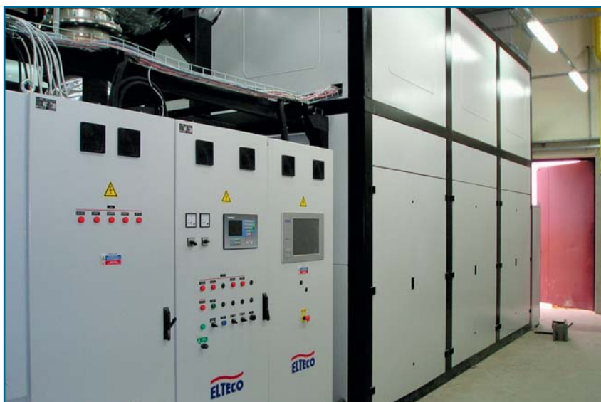
Rys 1. Obudowa dźwiękochłonna kogeneratorsa wraz z szafami sterującymi.
