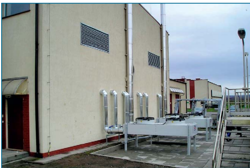
Rys 1. Obudowa dźwiękochłonna kogeneratora wraz z szafami sterującymi.
